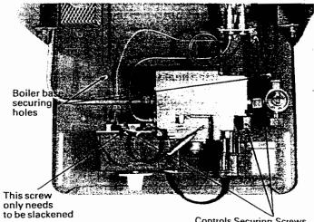
Fig. 16. Securing Screws
